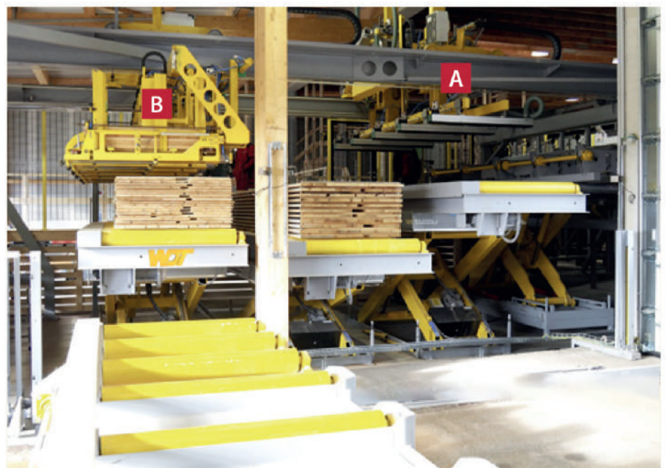
Der Vakuumheber (A) hebt die Lagen auf einen der zugewiesenen Plätze, von links kommen die Stapellatten (B)
